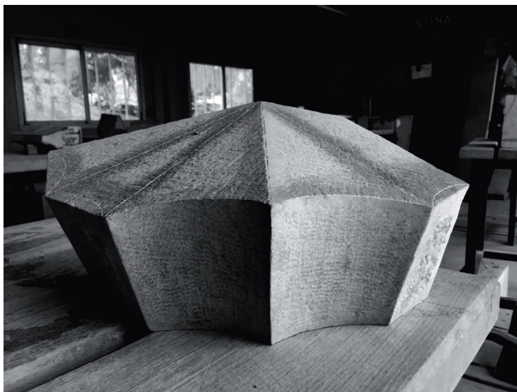
[fig. 14. Imagen de un arranque labrado en de acceso a la Capilla Real, con piedra, con su forma de “corona” el “senyal” de Aragón. (Imagen de A. Zaragoza)]
